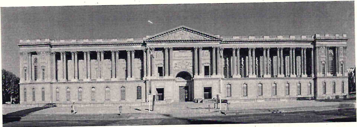
2. Клод Перро. Восточная колоннада Лувра
