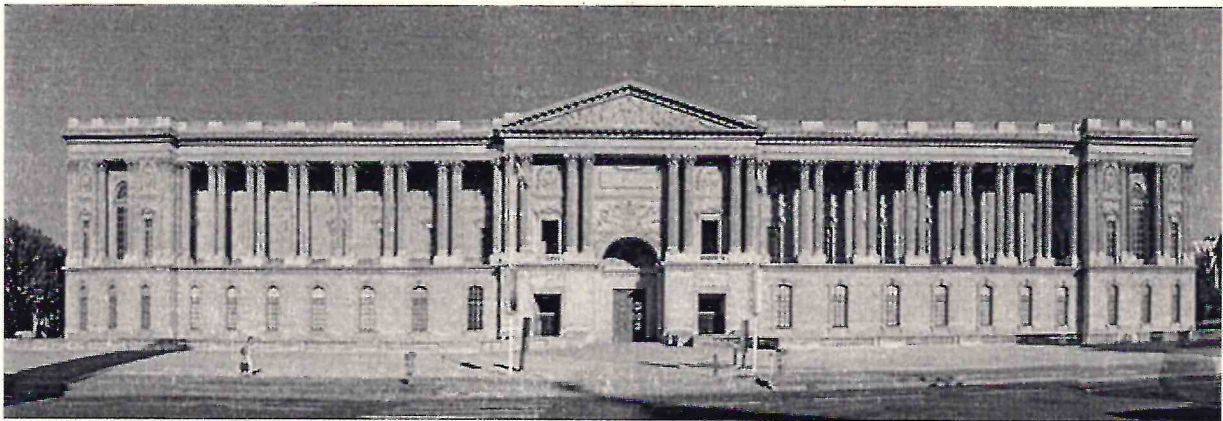
2. Клод Перро. Восточная колоннада Лувра
