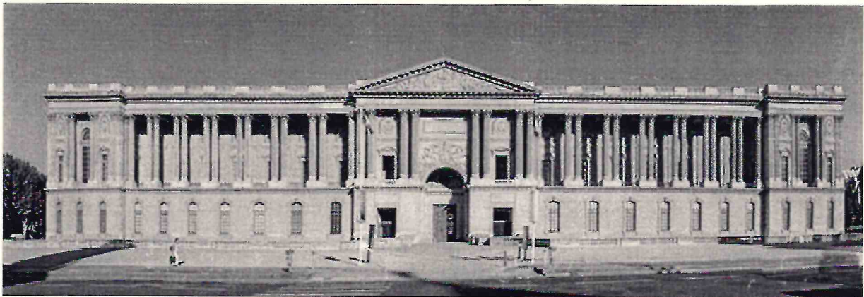
2. Клод Перро. Восточная колоннада Лувра
